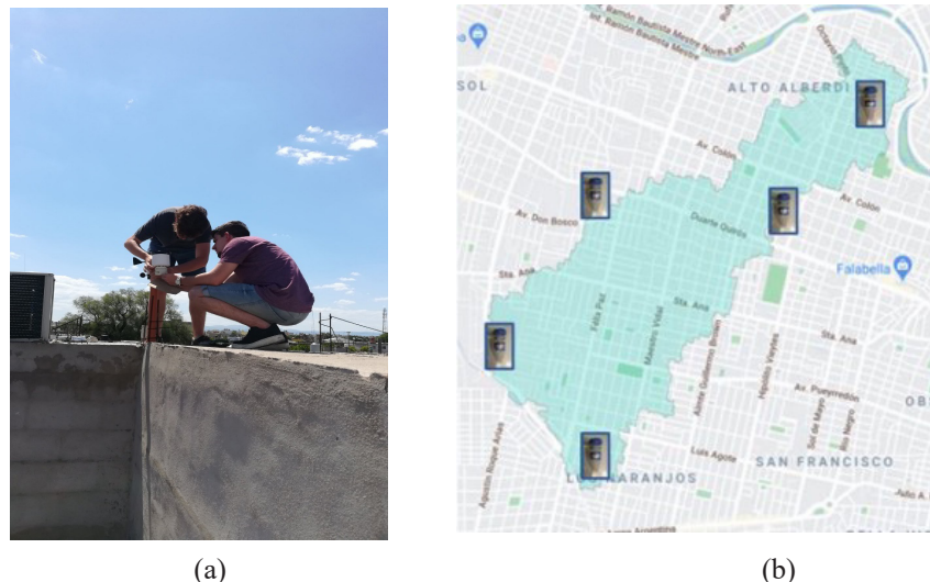
Figura 3. a) Instalación de estación meteorológica en vivienda de vecina, en el marco del “Proyecto MATTEO”, y b) ubicación de los pluviómetros en viviendas particulares de vecinos en la cuenca. Fuente: Elaboración propia.
