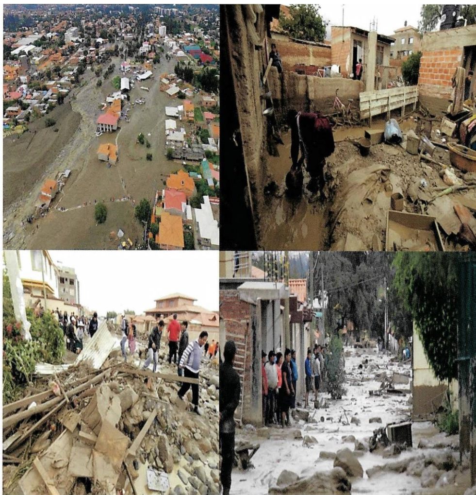
Figura N°2. Daños provocados por el flujo de la Mazamorra Bolivia - Departamento de Cochabamba - Municipio de Tiquipaya - Bolivia
