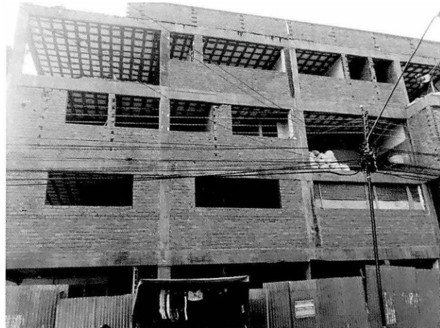
Figura Nº 2. Hospital materno infantil, vista sur de la infraestructura
