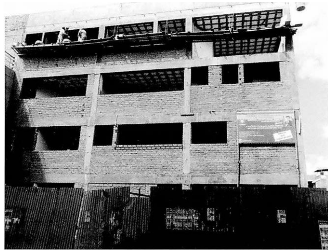
Figura Nº 1. Hospital materno infantil, vista oeste de la infraestructura
