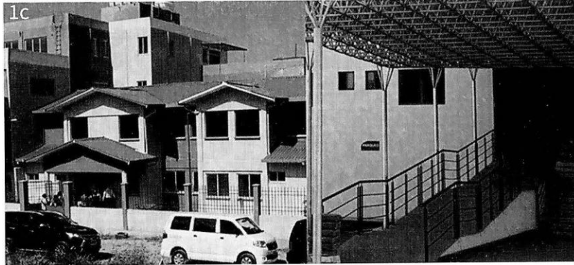
Hospital del norte y sur en la ciudad de Cochabamba que no se utilizan a pesar de ser infraestructuras nuevas
