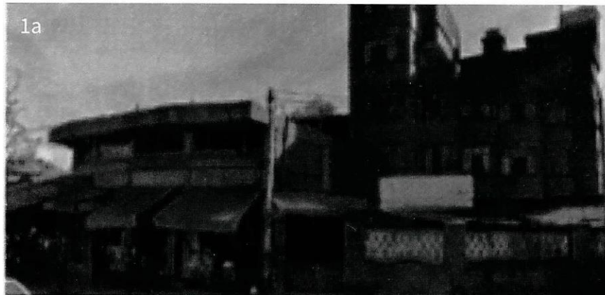
Edificios de uso múltiple (vivienda y comercio), en el que se observa el deterioro del espacio y por ende se percibe poca habitabilidad del mismo
