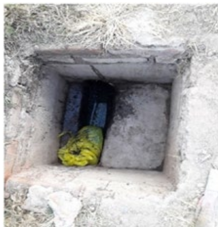
Figura N°3. Cámara de recepción del Biol
